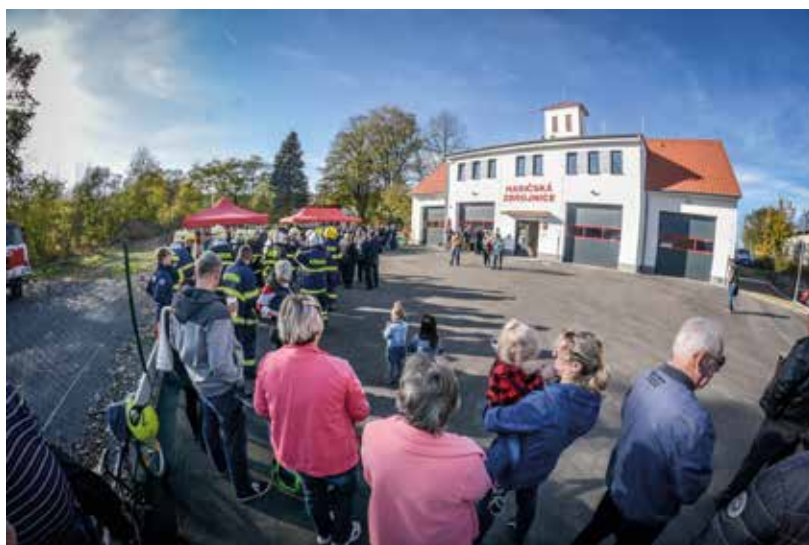
Hasičská zbrojnice - celkový pohled
